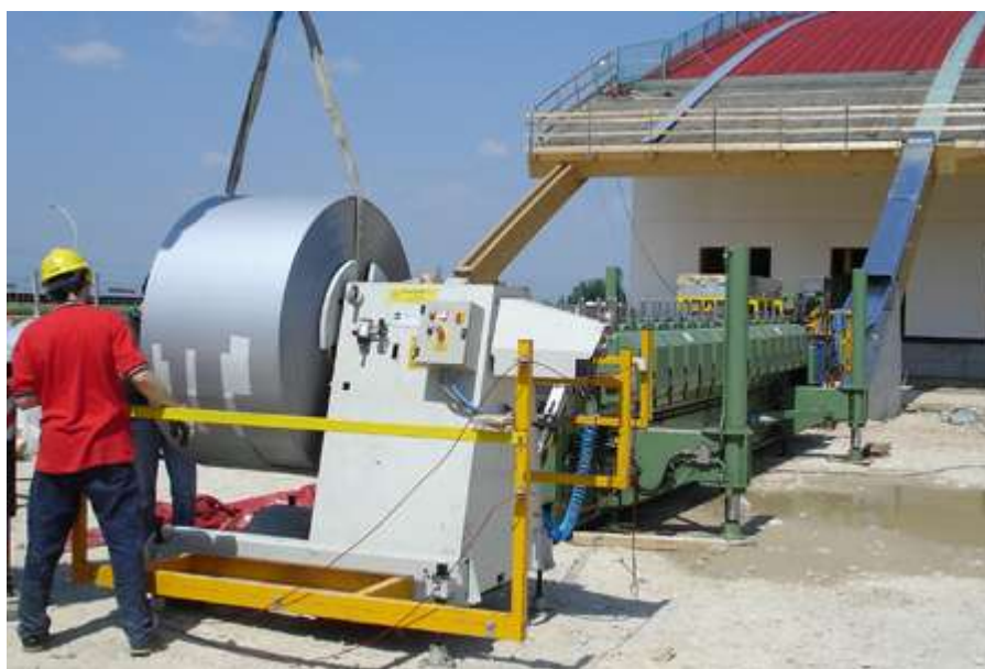
Produkcja paneli z wstęgi na placu budowy
